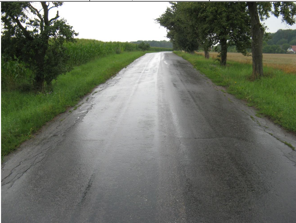
F38, km 3,110+ Síťové trhliny podél obou okrajů vozovky.
