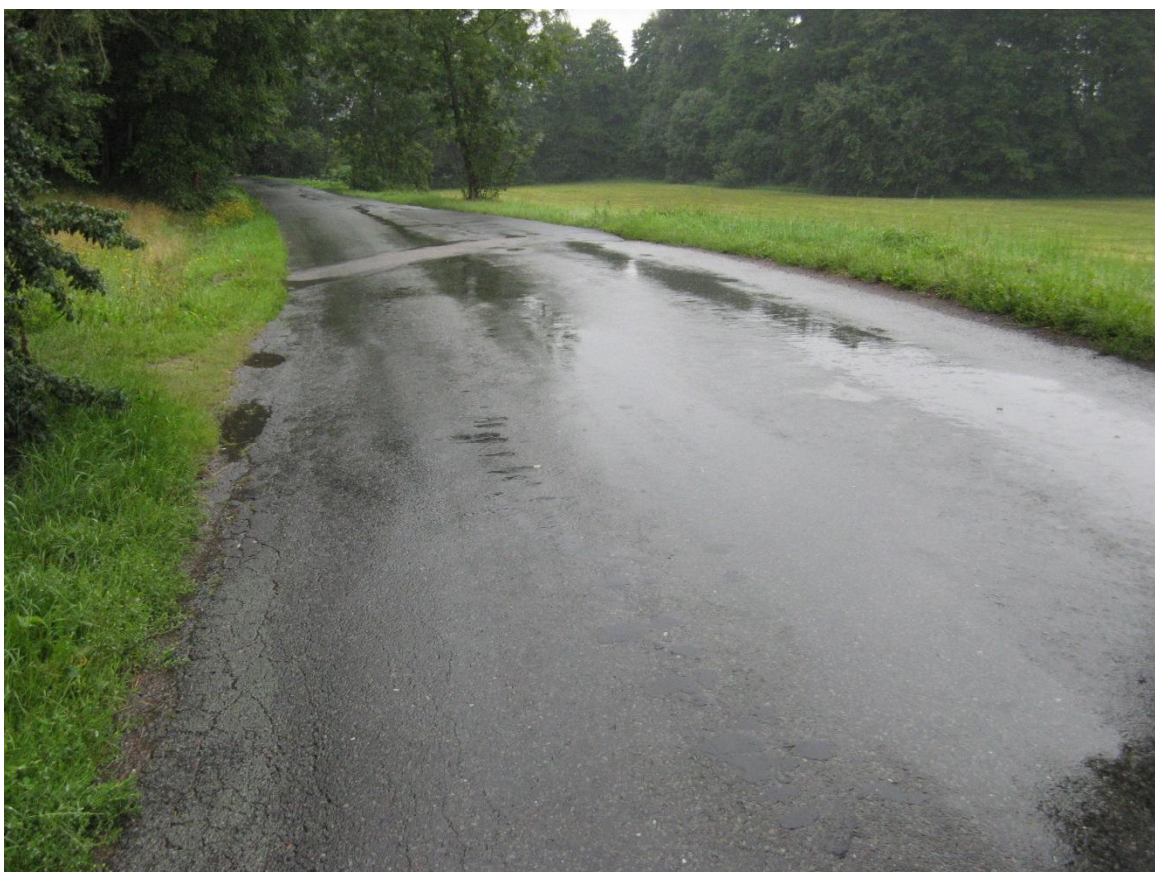
F15, km 0,350- Síťové trhliny a deformace podél okraje vozovky.
