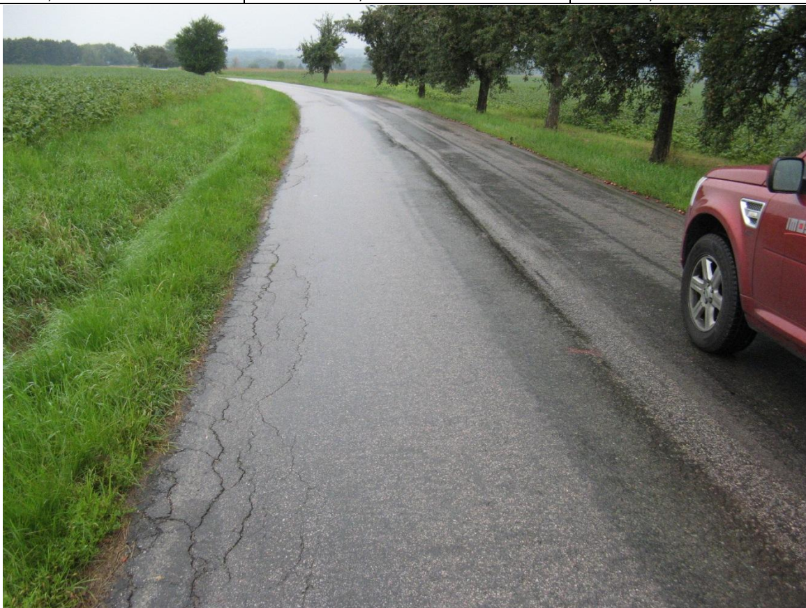
F10, km 1,800+ Síťové trhliny.
