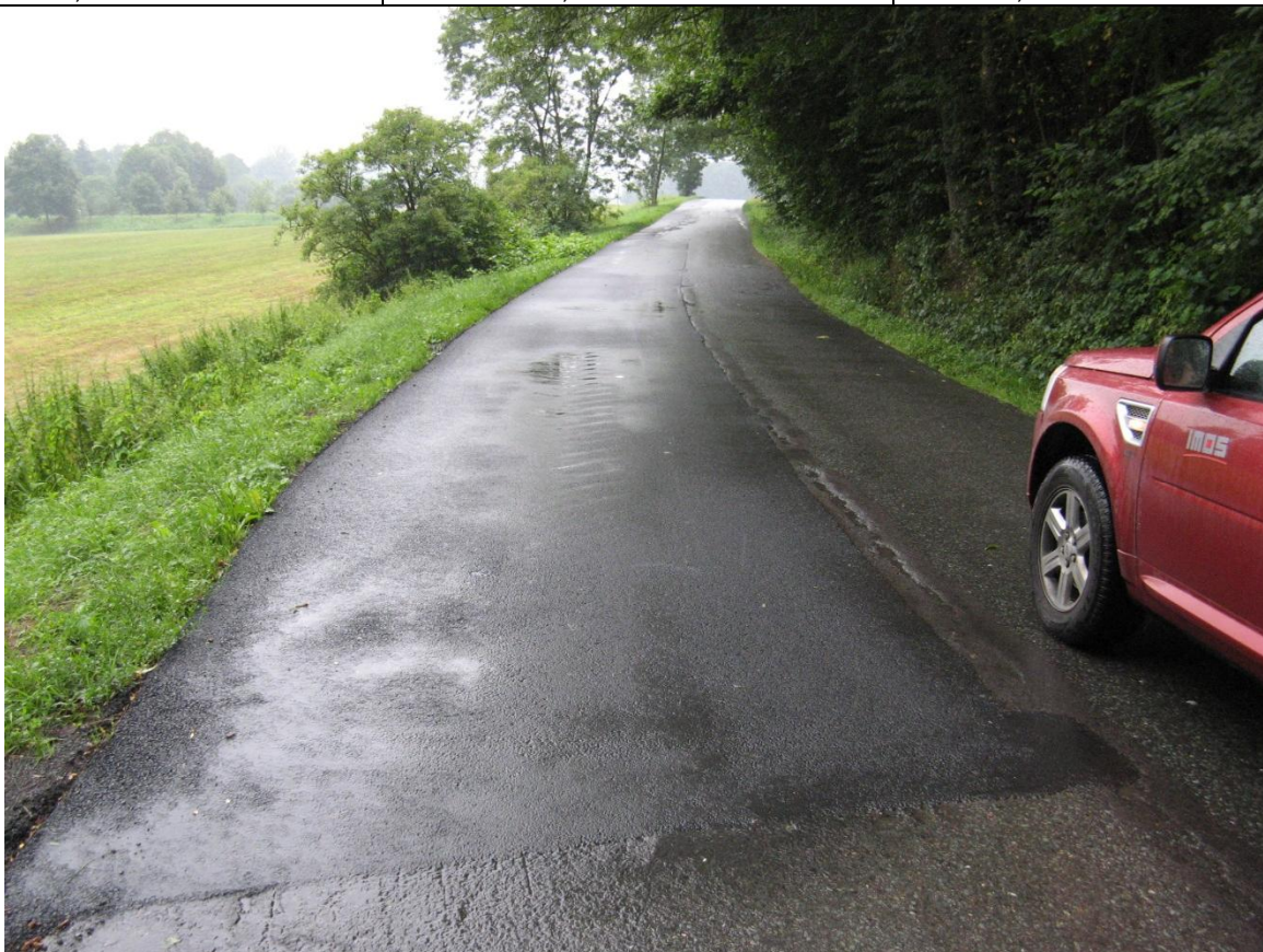
F10, km 0,210+ Velkoplošná vysrávka. Původní povrch s korozí.
